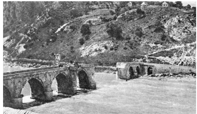
Вишеградски мост срушен
