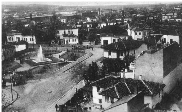
Сл. 25. – Трг Краљице Наталије након реконструкције 1932. године.
